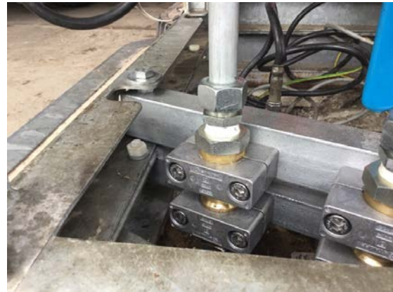
Abbildung 15: Halterung Rohrbruchsicherung formschlüssig
