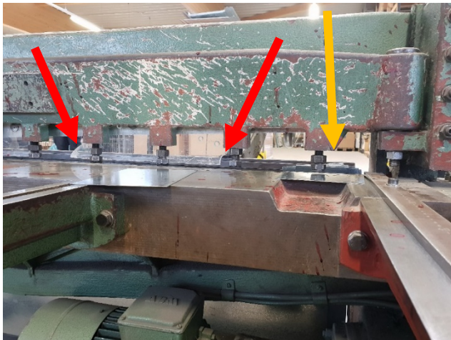
Abbildung 16: Gefahrenstelle mit defektem Schnittlinienschutz (rot) und Unfallstelle (gelb)
