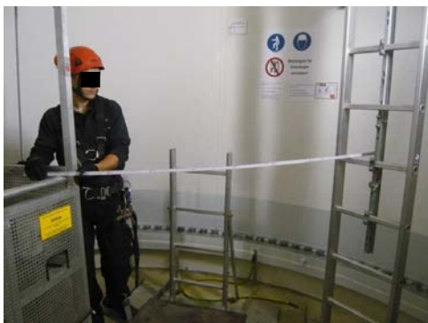
Abbildung 9: Abstand Fahrkorb / Steigleiter
