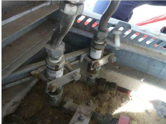
Abbildung 14: Rohrbruchsicherung kraftschlüssig mittels Klemmblechen
